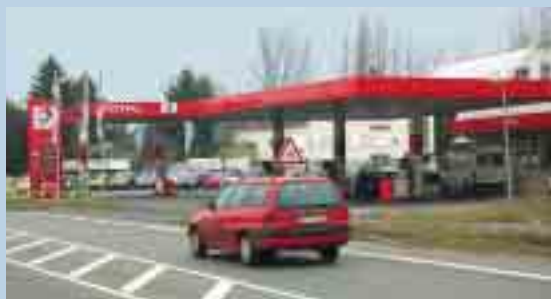
Projektierte Erdgastankstelle in Dreieich
